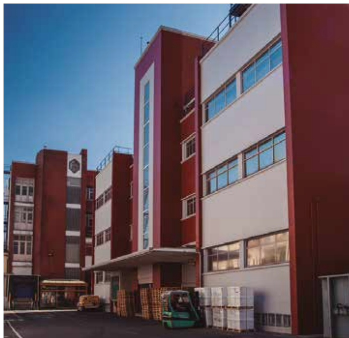
Instalaciones de Faes Farma en Leioa (Bizkaia).
