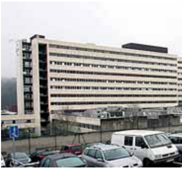
Hospital de Galdakao.
